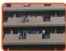
集合住宅の廊下・ロビー
